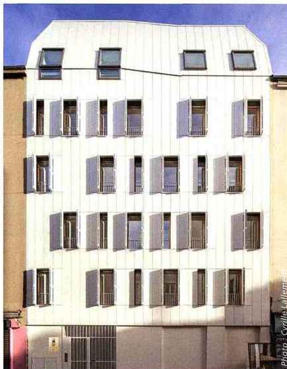
▲ Immeuble R+5 situé rue Dezobry à Saint-Denis (93), abritant dix logements sociaux. La structure est constituée à 80 % de bois (CLT + L-C). Projet : JTB Architecture. Réalisation : BâtiPlaine pour Plaine Commune Habitat et 3F.
