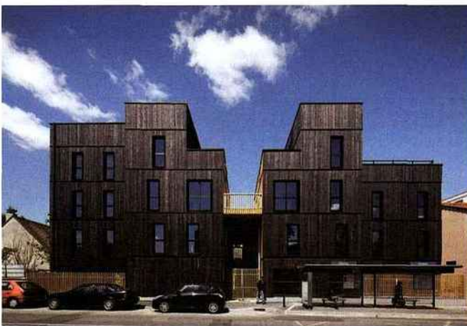
▲ Trente-cinq logements sociaux dans le quartier Branly-Boissière à Montreuil (93). L'opération est répartie dans deux ensembles en ossature bois préfabriquée, rue Étienne-Dolet (R+2) et rue Édouard-Branly (R+1 et R+2). Projet : LA Architectures (75) pour l'OPH de Montreuil.
