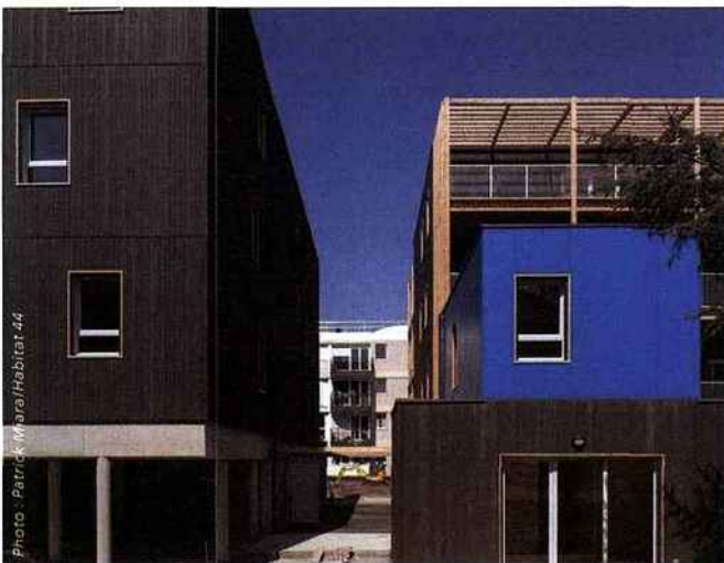
▲ La Boétie à Ancenis (44). La résidence est constituée de dix-sept habitations : quinze logements collectifs, répartis en deux plots desservis par deux cages d'escaliers et deux logements individuels avec terrasse et jardinets, réalisés avec des modules tridimensionnels à ossature bois, fabriqués et prééquipés en usine. Architecte : Tetrarc. Maître d'ouvrage : Habitat 44.
