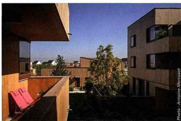
▲ Le quartier du Chêne Saint-Fiacre à Chanteloup-en-Brie (77) : un immeuble collectif R+2 de vingt logements (structure porteuse en béton armé + enveloppe à ossature bois) et quarante maisons individuelles (à ossature bois) adossées ou superposées. Projet : Jean et Aline Harari (75) pour Résidence urbaine de France (75).
