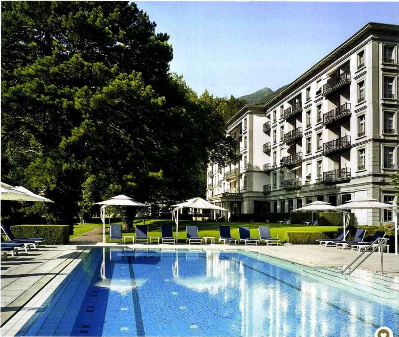
Les eaux thermales à 36,5° provenant des sources de Tamina The body-temperature thermal water from the nearby Tamina gorge
